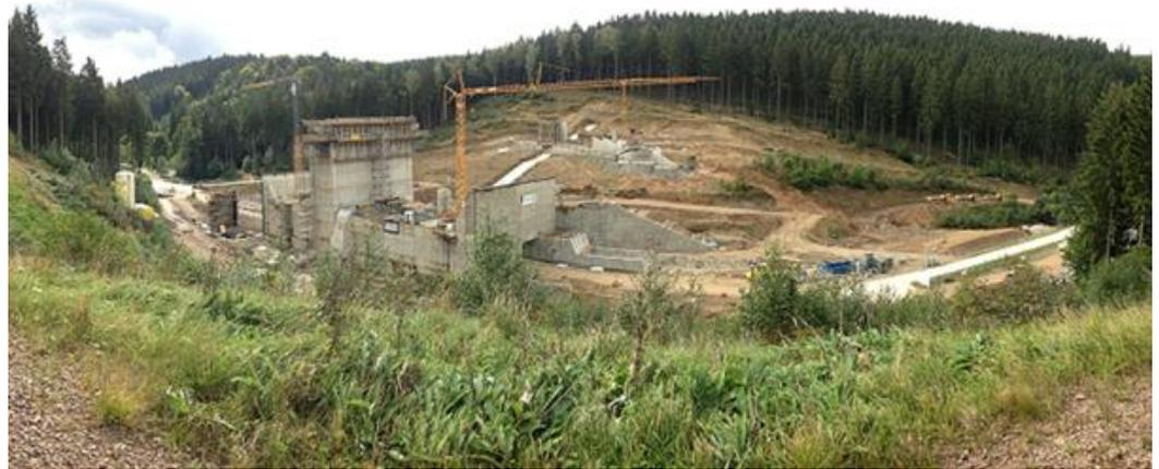
Abbildung 2: Großbaustelle eines Hochwasserrückhaltebeckens am Uran-Altstandort Niederpöbel
