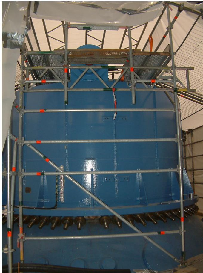
Hier geschah der Wassereinbruch. Oberhalb des Schraubenschranks befindet sich der Wärmetauscher, aus dem über 25 Tonnen Wasser in den darunterliegenden Reaktor gelangten.
