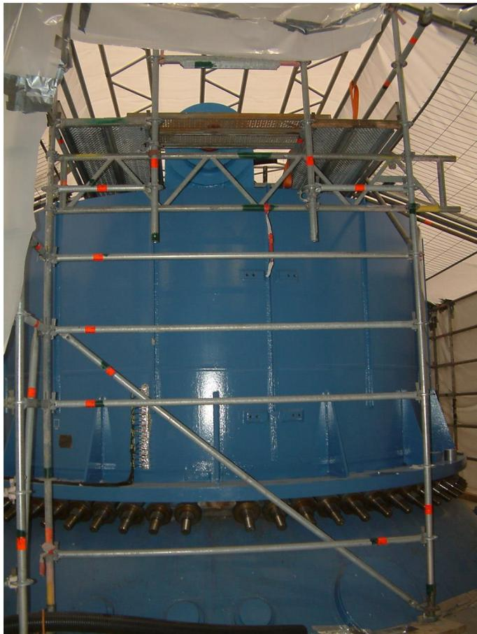
Hier geschah der Wassereinbruch. Oberhalb des Schraubenzantrages befindet sich der Wärmetauscher, aus dem über 25 Tonnen Wasser in den darunterliegenden Reaktor gelangten.
