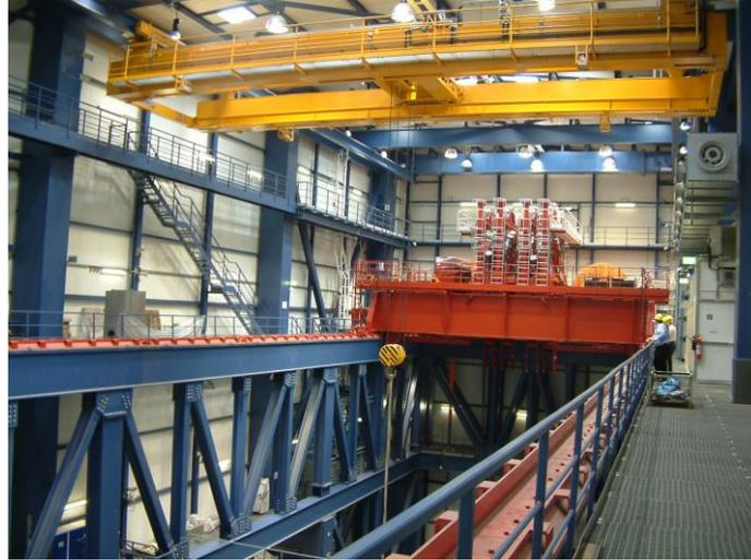
Auf der oberen Etage der Sicherheitsschleuse, in der Luft-Unterdruck herrscht. Auf Schienen befindet sich der Kran (hinten), der das mit einem Spezialbeton verfüllte, 2.100 Tonnen schwere Reaktordruckgefäß, in dem sich noch 197 zerborstene Brennelemente befinden, in einem Stück auf einem 81-achsigen Spezialfahrzeug ablegen soll. (Foto: © Jürgen Streich)
