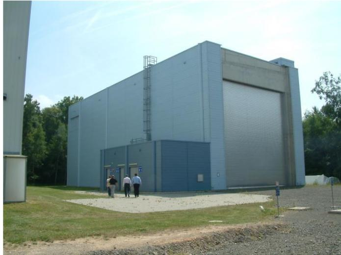
Das AVR-Zwischenlager, in dem der Reaktor mehrere Jahrzehnte abklingen soll, bevor er zerlegt und endgelagert werden kann.
