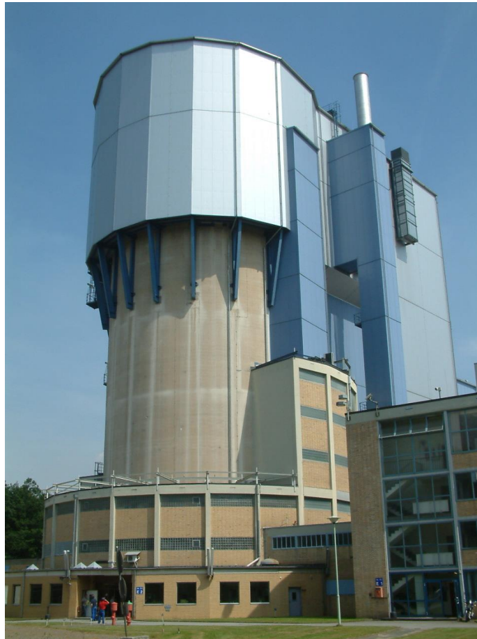
Das AVR-Gebäude. Die obere Umhüllung ist Teil des „sicheren Einschusses“, die in die dahinterliegende Sicherheitsschleuse übergeht, durch die der herausgehobene Reaktor auf ein Spezialfahrzeug abgelegt werden soll. (Foto: © Jürgen Streich)
