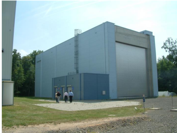
Das AVR-Zwischenlager, in dem der Reaktor mehrere Jahrzehnte abklingen soll, bevor er zerlegt und endgelagert werden kann. (Foto: © Jürgen Streich)
