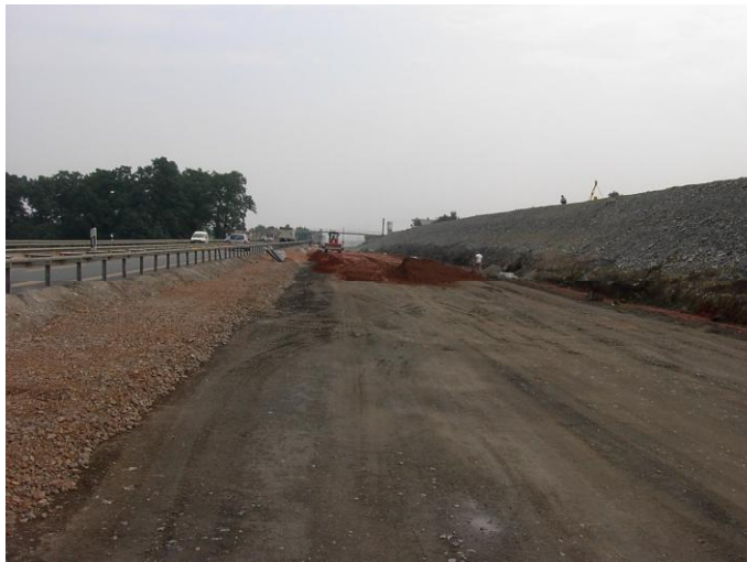
Abbildung 6: Wiedereinbau von zementverfestigtem kontaminiertem altem Tragschichtmaterial auf der Bundesautobahn (BAB) 72 Chemnitz-Zwickau (Foto nach [14])
